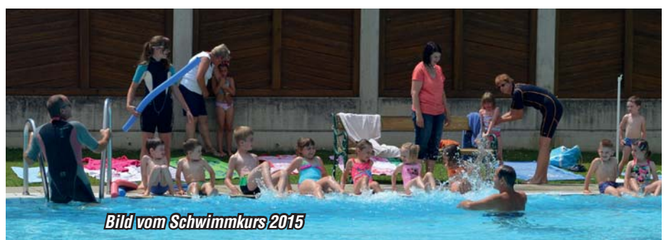
Im Schwimmbad wurden die Sanitäranlagen provisorisch erneuert und um Duschkabinen erweitert. Das Ganze in Containerbauweise.
