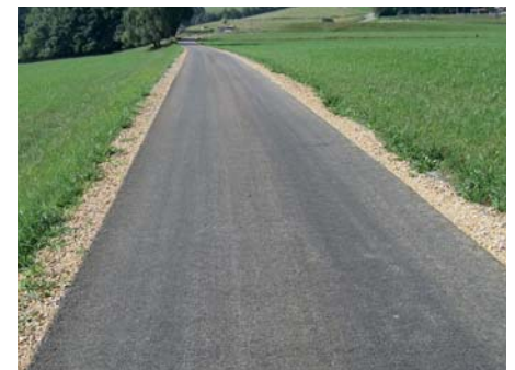
Straßensanierung beim Kuchler- und Kummerweg in Neudorf
