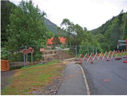
Baustelle Jakobibrücke in Arzberg Voraussichtliche Fertigstellung: 2. Oktober 2015
