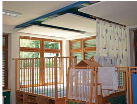
Sanierungen im Kindergarten Arzberg: Akustikdecke und kleinere Sanierungsmaßnahmen
