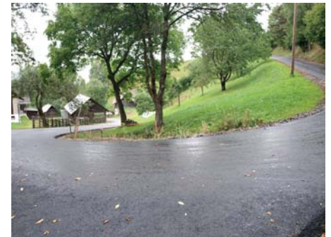
Straßensanierung in Burgstall und im Geigental in Arzberg
