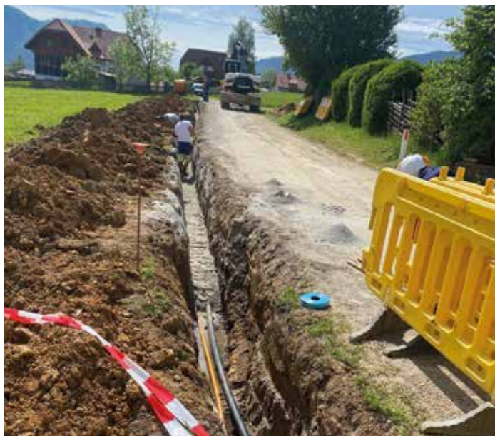
Sanierung/Erweiterung Wasserleitung Hart
