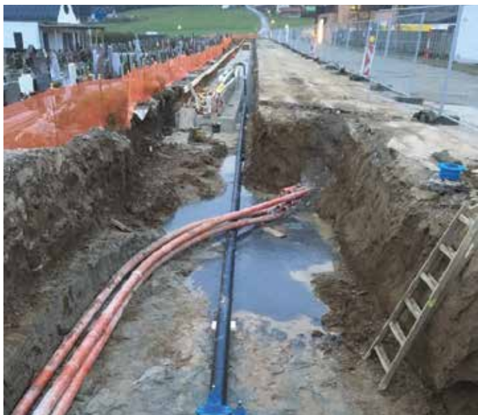
Sanierung und Erweiterung der Wasserleitung in der Wiedenbergstraße
