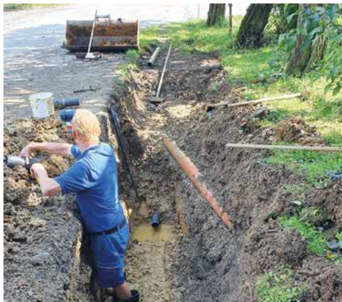
Wasserrohrbruch Hart
