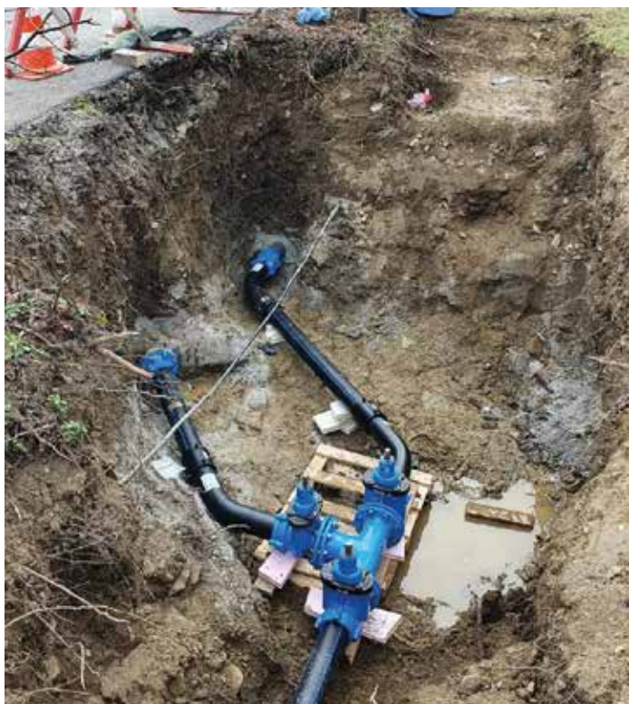
Sanierung/Erweiterung Wasserleitung Weizer Straße
