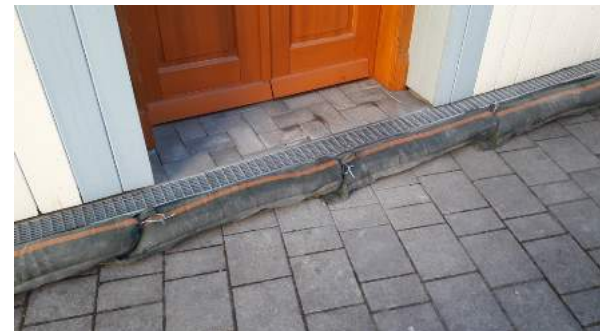
Einfacher Eingangsbereich-Schutz bei kleiner Überschwemmung
