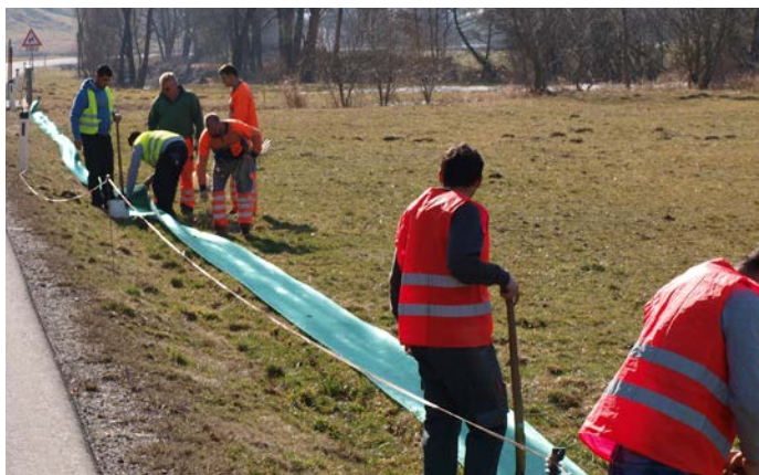
Asylwerber, Straßenverwaltung und Gemeindearbeiter beim Aufbauen eines Amphibienzaunes in Richtung Arzberg
