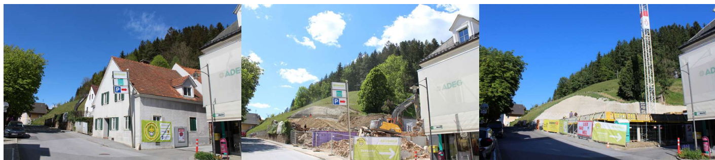
Baufortschritt in Bildern Stand Ende August aus Sicht vom Markt
