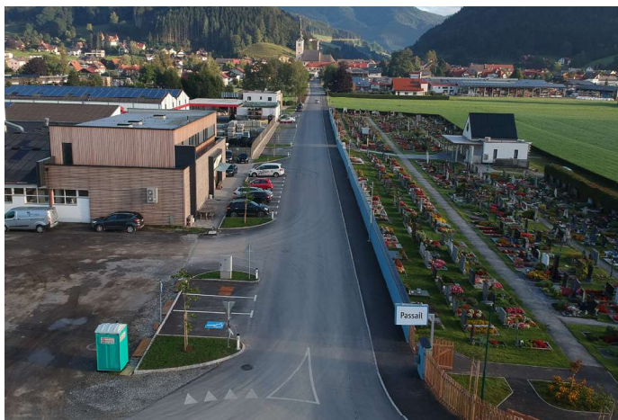
Über 550 Laufmeter Straße und Gehsteig wurden neu gemacht
