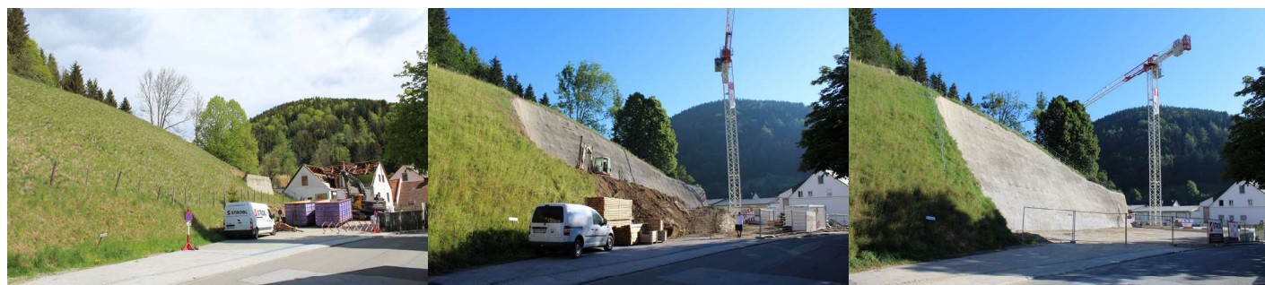
Baufortschritt in Bildern Stand Ende August aus Sicht der Fladnitzer Straße
