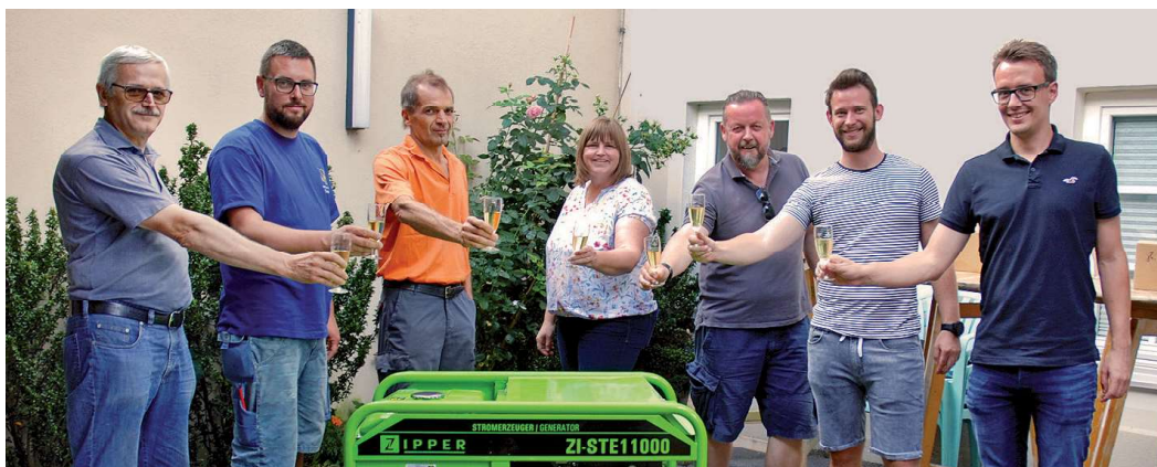
Das neue Notstromaggregat wurde symbolisch mit Sekt „getauft“. Vielen Dank an alle Beteiligten.
