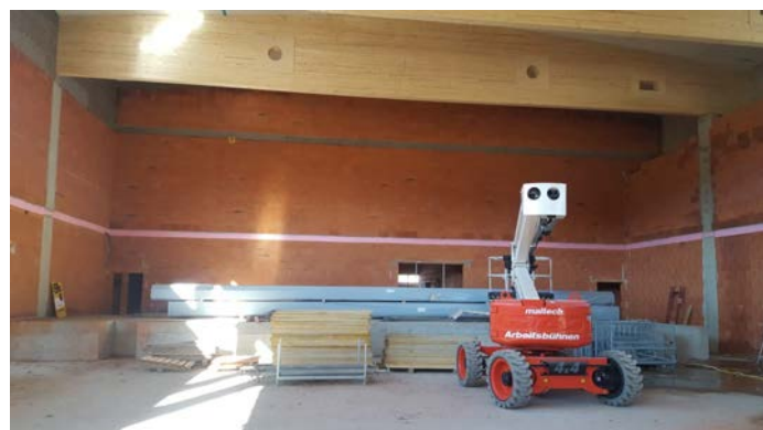
Ansicht Richtung Bühnen/Tribünenbereich
