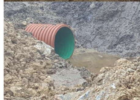
Die Oberflächenentwässerung im Bereich Flurweg nimmt Formen an.
