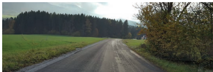
Die Straße nach Krammersdorf wurde saniert.
