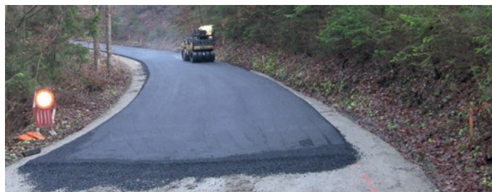
Vorerst abgeschlossen: Arbeiten an der Hochstraße
