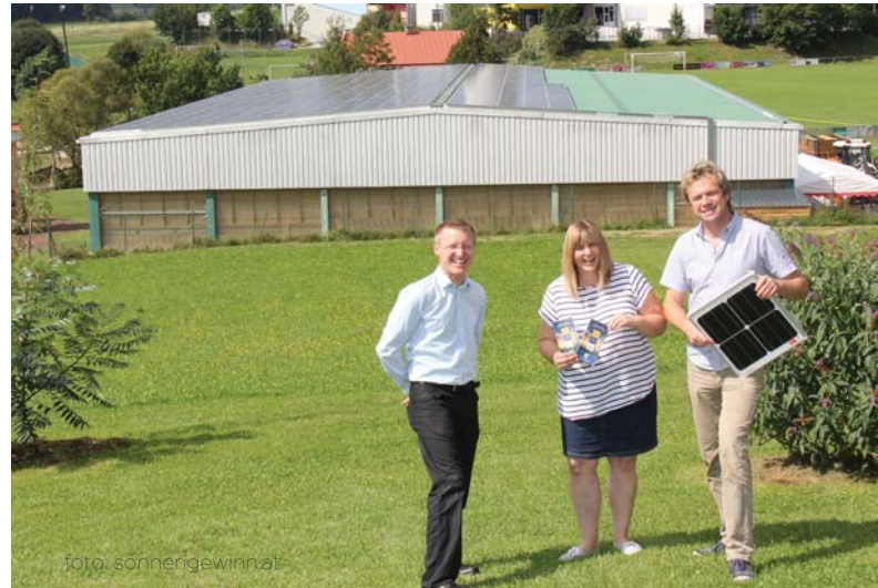
Hubert Steiner, Bgm. Eva Karrer und Thomas Reisinger vor der 120kW Photovoltaik-Anlage auf der Stocksporthalle Passail
